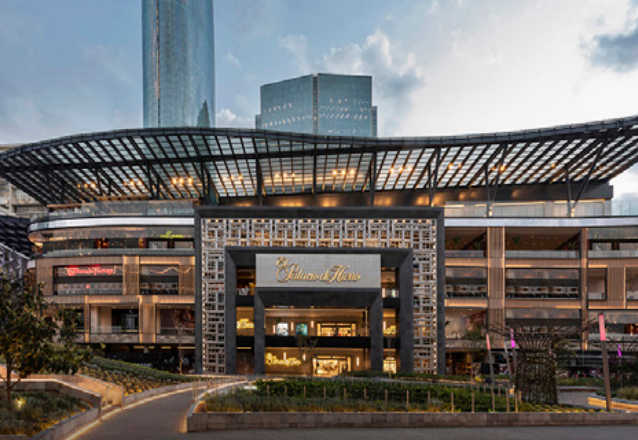
EL PALACIO DE HIERRO COYOACÁN
