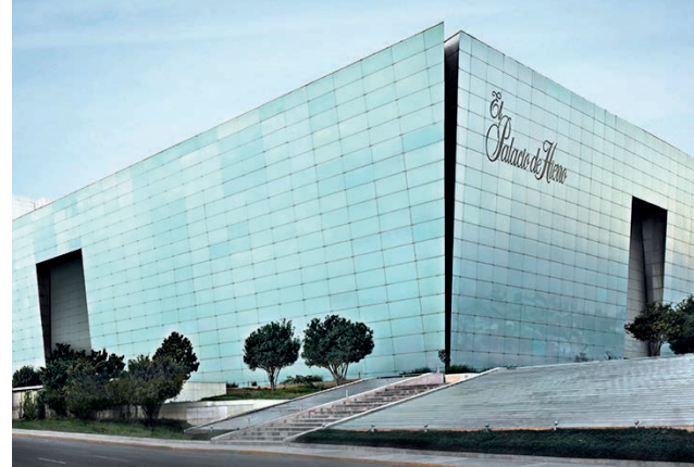
■ EL PALACIO DE HIERRO MONTERREY
